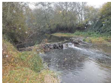
Ardoux Barrage Novembre 2016
