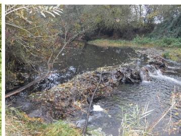
Barrage endommagé Novembre 2016
