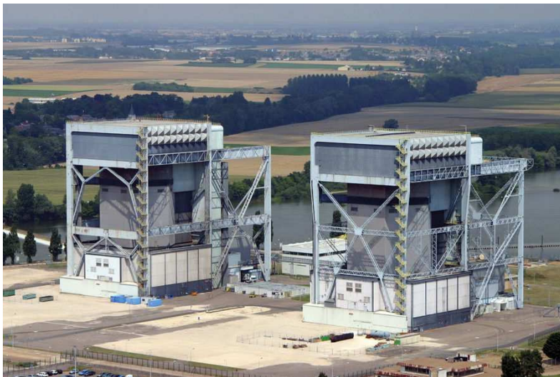
Les deux caissons des réacteurs nucléaires graphite de la centrale de Saint-Laurent-des-Eaux (Loir-et-Cher). ASN
